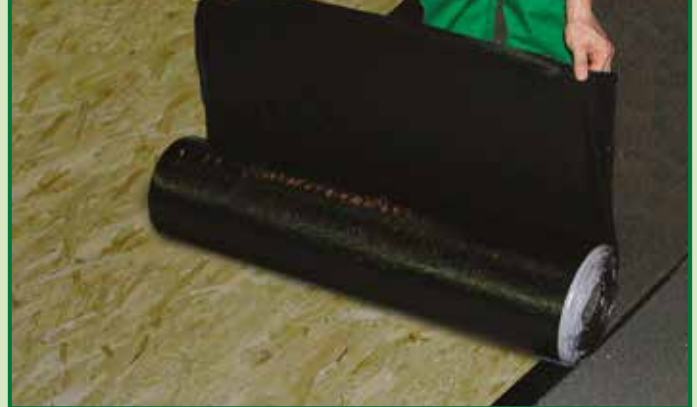
Posa a freddo per semplice pressione delle membrane autoadesive SELFTENE
