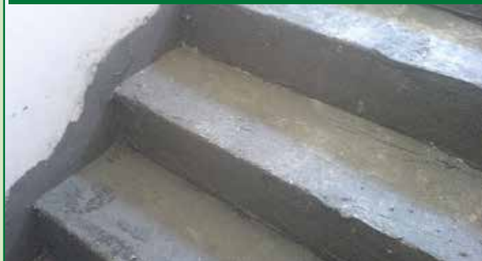
FONOPLAST impiegato sui gradini per l'attenuazione dei rumori delle scale
