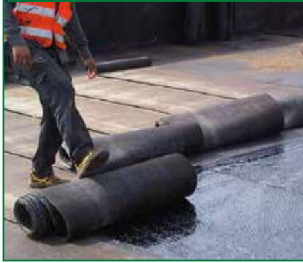
5. POSA DELL'ARMATURA RINFOTEX EXTRA
