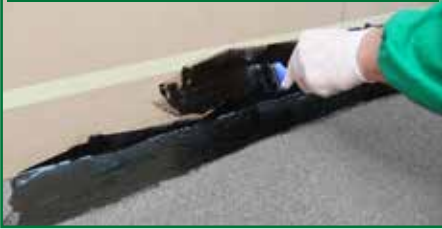
7. SECONDA MANO DI PURLASTIC FLASHING
