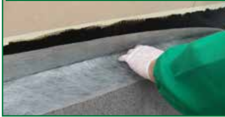
8. RIMOZIONE DEL NASTRO PROTETTIVO PRECEDENTEMENTE APPLICATO
