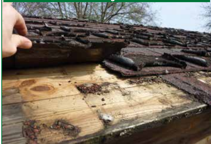
Prima: copertura con vecchie tegole bituminose
