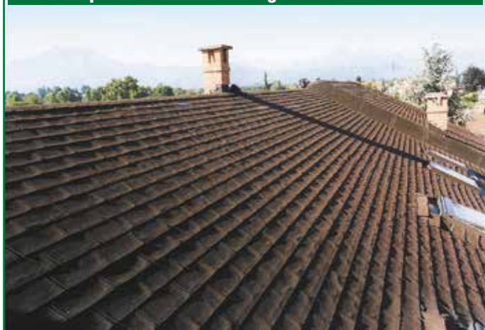
Prima: copertura con vecchie tegole bituminose
