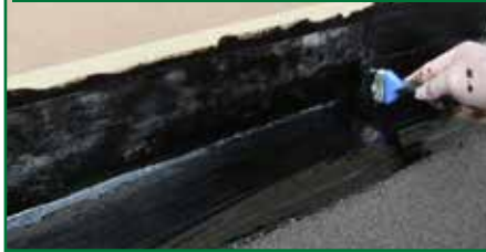
8. RIMOZIONE DEL NASTRO PROTETTIVO PRECEDENTEMENTE APPLICATO
