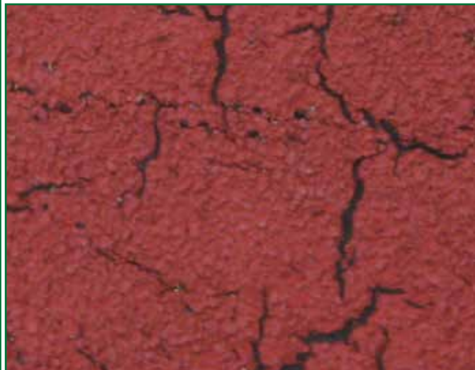
COCCODRILLATURA DI SUPERFICI BITUMINOSE ARDESiate PER ECCESSO DI SPESSORE DI BITUME SULL'ARMATURA, MA DOPO 30 ANNI IL MANTO È ANCORA A TENUTA D'ACQUA
