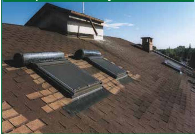
Prima: copertura con vecchie tegole bituminose
