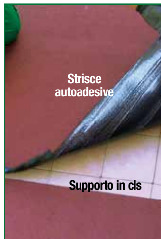
Rimozione del film siliconato
