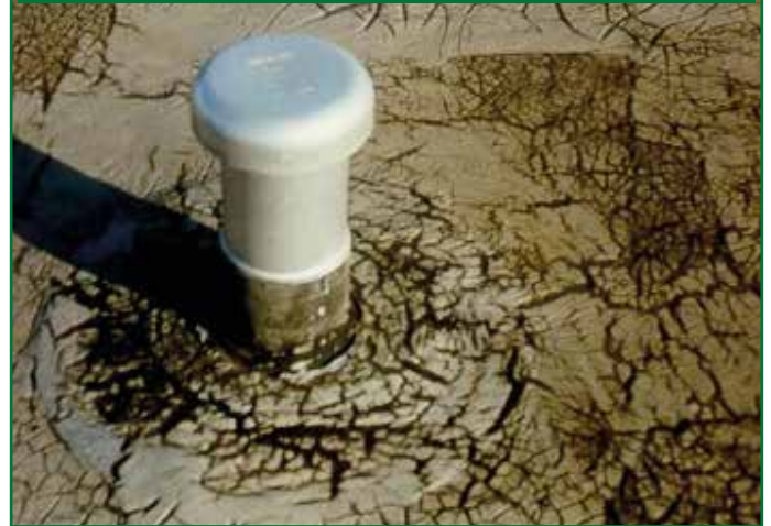
COCCODRILLATURA DI SUPERFICI BITUMINOSE ARDESiate PER ECCESSO DI SPESSORE DI BITUME SULL'ARMATURA, MA DOPO 30 ANNI IL MANTO È ANCORA A TENUTA D'ACQUA
