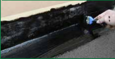
7. SECONDA MANO DI PURLASTIC FLASHING
