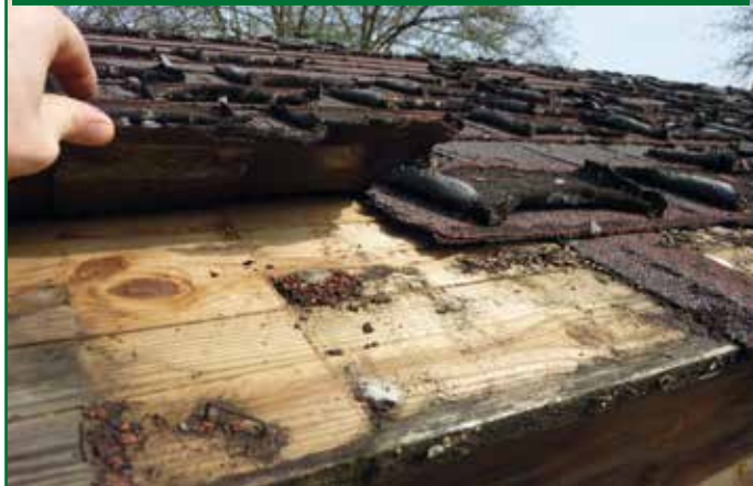
PRIMA: COPERTURA CON VECCHIE TEGOLE BITUMINOSE
