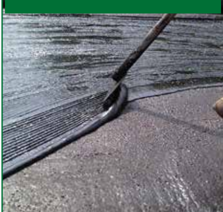
1. POSA DELL'ADESIVO MASTIPOL
