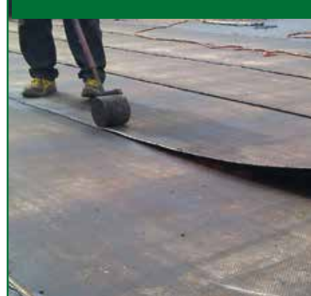
3. SALDATURA A FIAMMA DEI SORMONTI
