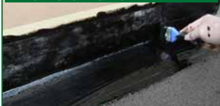
7. SECONDA MANO DI PURLASTIC FLASHING
