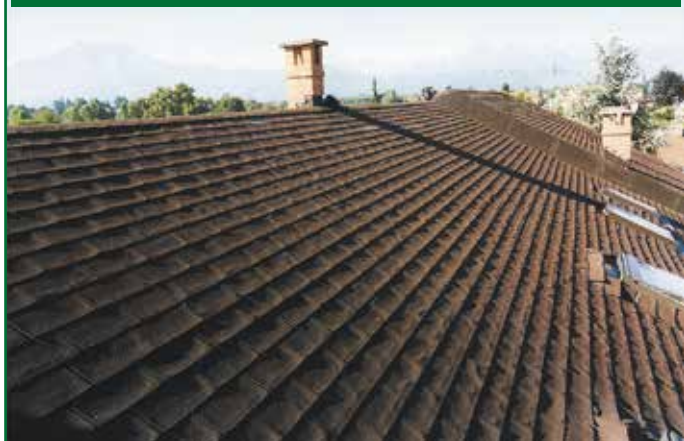
PRIMA: COPERTURA CON VECCHIE TEGOLE BITUMINOSE
