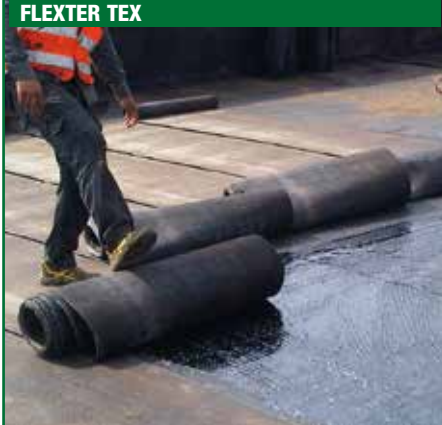
5. POSA DELL'ARMATURA RINFOTEX EXTRA
