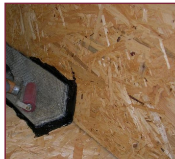
3. Si pressa accuratamente la fascia di rinforzo
