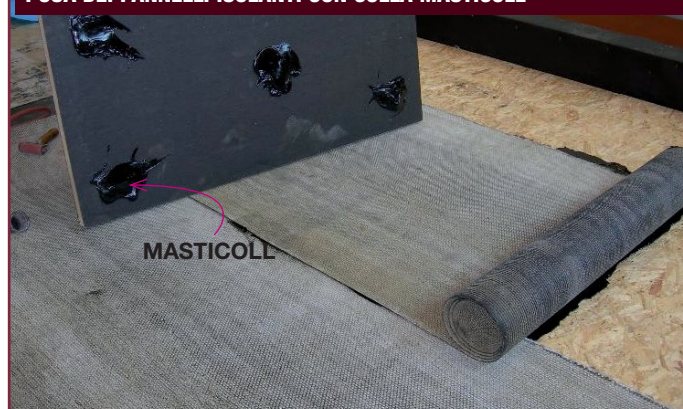
POSA DEI PANNELLI ISOLANTI CON COLLA MASTICOLL
