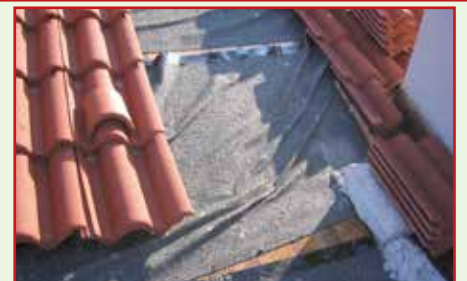
8. Pressatura generale prima della posa delle tegole
