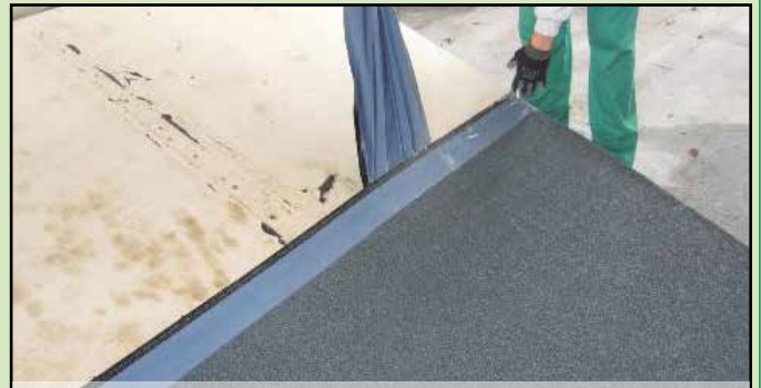
2. Incollare per autoadesione la membrana
