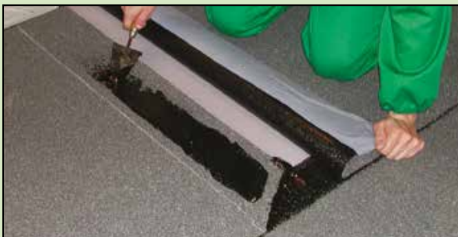
7. Saldare le sovrapposizioni di testa con HEADCOLL
