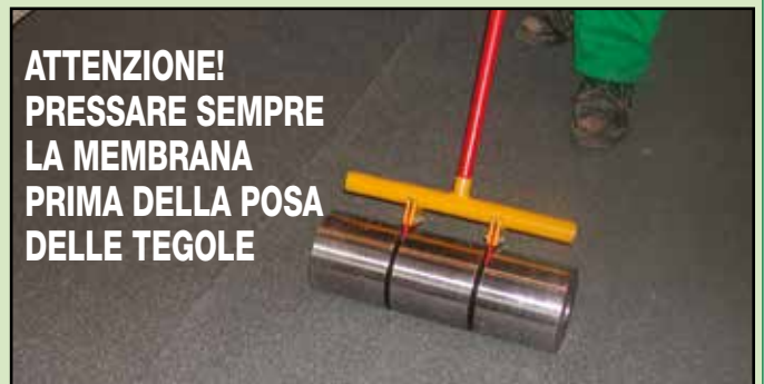
8. Pressatura generale prima della posa delle tegole
